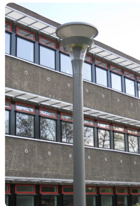
Den nye LED-parklampe i funktion ved Albertslund Rådhus.
